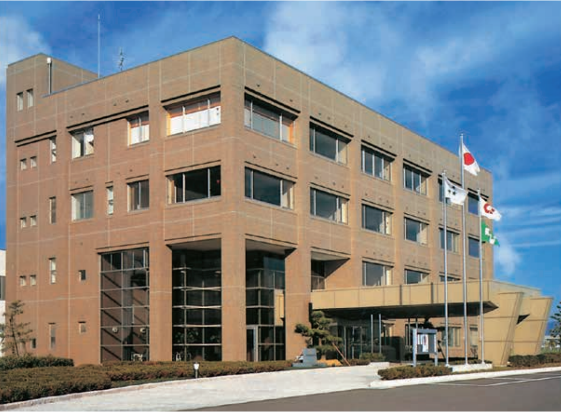
事務所棟外観
